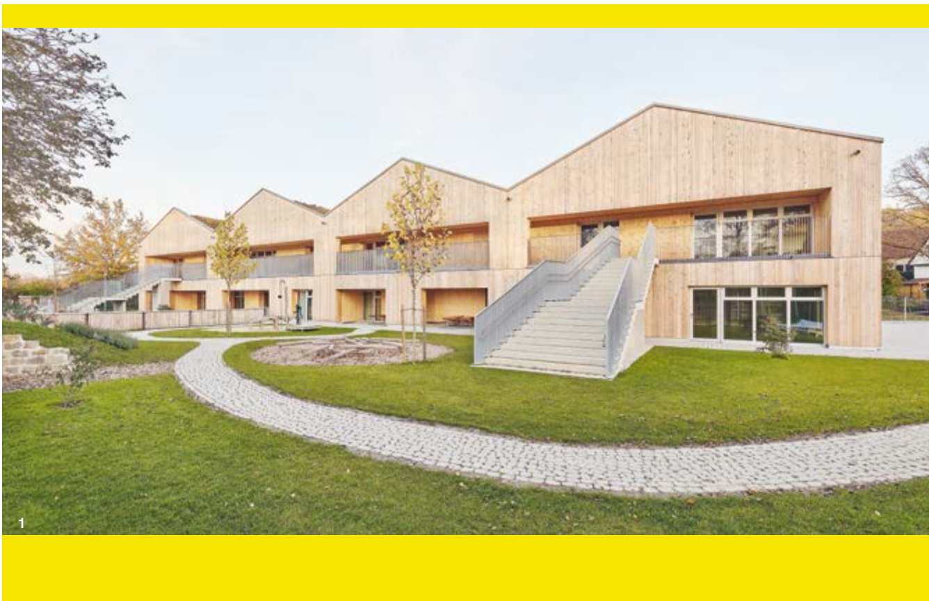
1 + 2 Die Kindertagesstätte Illerkirchberg, 2021 in Beton-Holz-Hybridbauweise fertiggestellt. Das Raumvolumen wird in vier zweigeschossige Satteldachhäuser aufgelöst, die in Reihe gestellt zu einer Einheit verschmelzen. Überdachte Terrassen und Balkone vermitteln auf der Gartenseite zwischen Innen und Außen.
