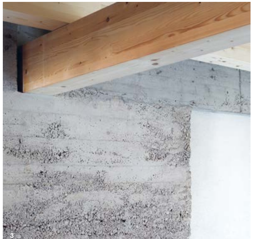
1 Der Derzbachhof in München-Forstenried wurde 1751 erbaut. Er ist heute das älteste Bauernhaus der Stadt München. Nach 40 Jahren Leerstand wurde er denkmalgerecht saniert und das Hofgrundstück mit einem zeitgenössischen Wohngebäude ergänzt. 2 + 3 Der Neubau des Derzbachhofs wurde in Hybridbauweise errichtet.
